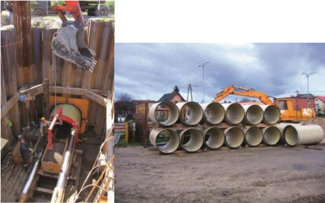
Abbildung 20: Startschacht (links) und Vortriebsrohre (rechts)
