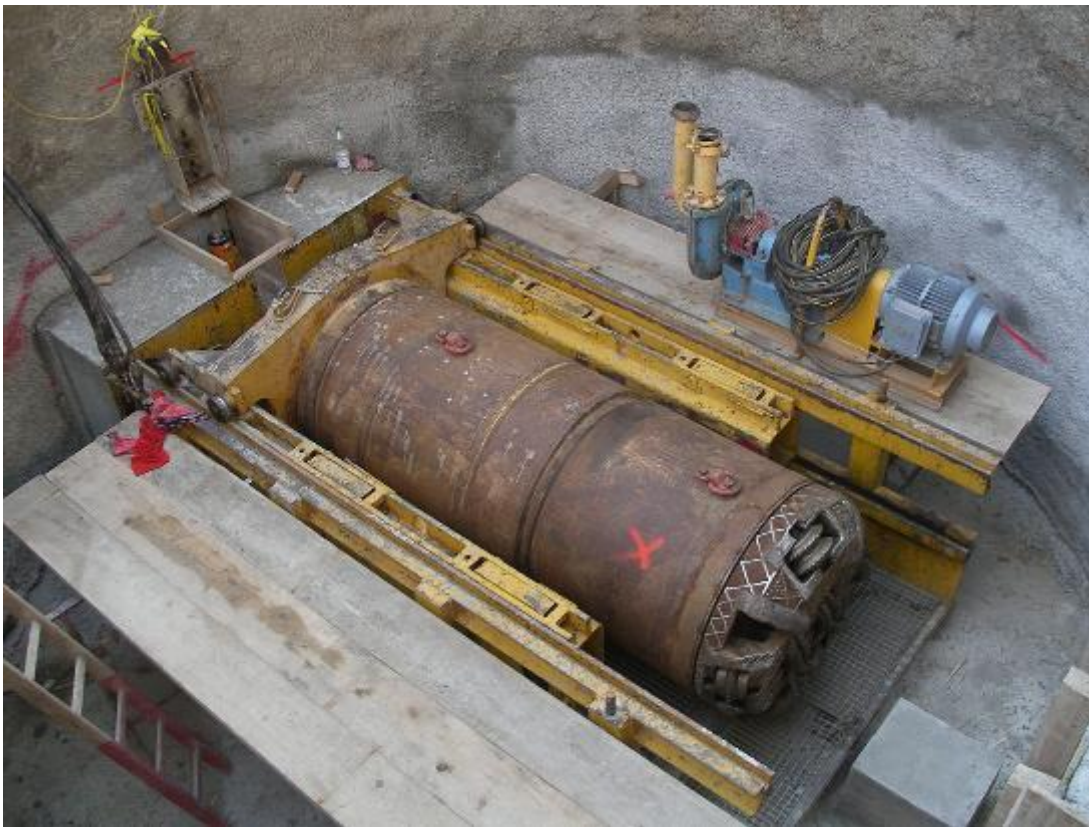
Abbildung 19: Bohrkopf mit hydraulischer Pressvorrichtung (oben)
