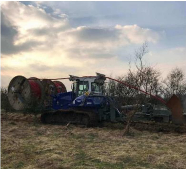
Abbildung 1: Pflügen mit modifizierter Raupenmaschine (Quelle: www.atpcableplough.com )
