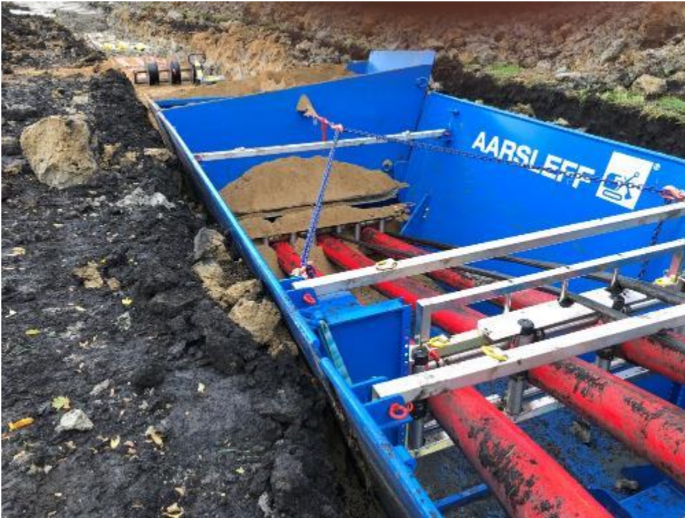
Abbildung 11: Trenchbox mit Schutzrohrführung und Sandtrichter (3 Schutzrohre statt 2 bei DC; im Hintergrund der wiederverfüllte Graben) (Quelle: TenneT)
