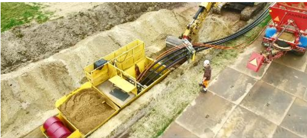
Abbildung 12: Trenchbox mit direkter Kabelverlegung ohne Schutzrohr (Quelle: Aarsleff)
