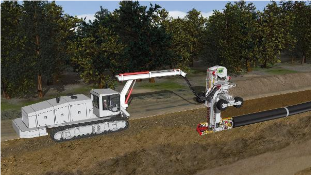
Abbildung 14: Unterstützungseinheit beim Pipe Thruster-Verfahren (Quelle: Herrenknecht)
