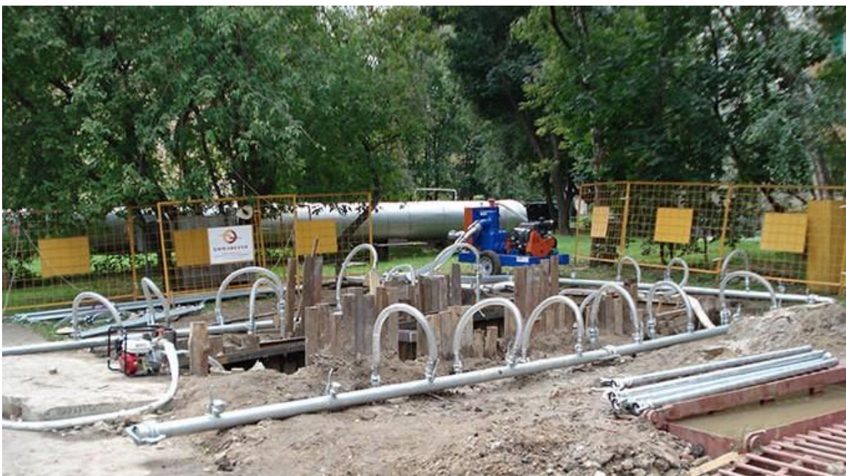
Abbildung 3: Beispiel einer lokalen Wasserhaltung mit Sauglanzen (Quelle: www.riesner-pumpen.de )
