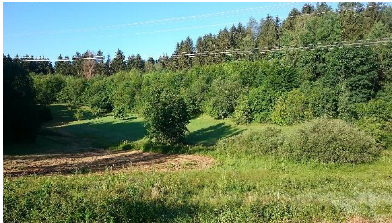
Abbildung 35: Schutzstreifen einer Freileitung östlich von Pettenreuth.
