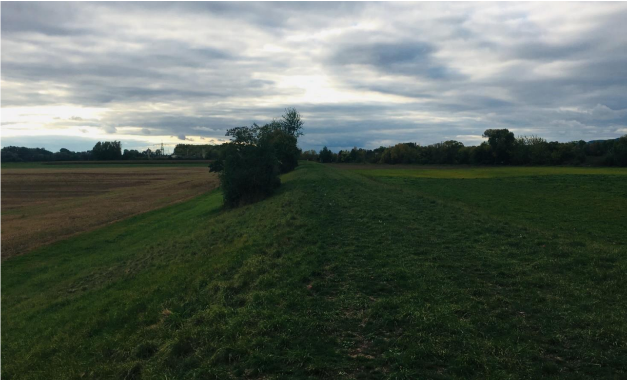
Abbildung 23: Blick von W-17 über den Hochwasserschutzdamm nach Westen.
