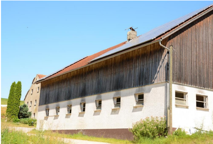
Abbildung 15: Schornstein eines Kuhstalls in der Ortschaft Göppenbach als Quartier der Fransenfledermaus im Umfeld des fTK im August 2020 (B_Mnat_1).
