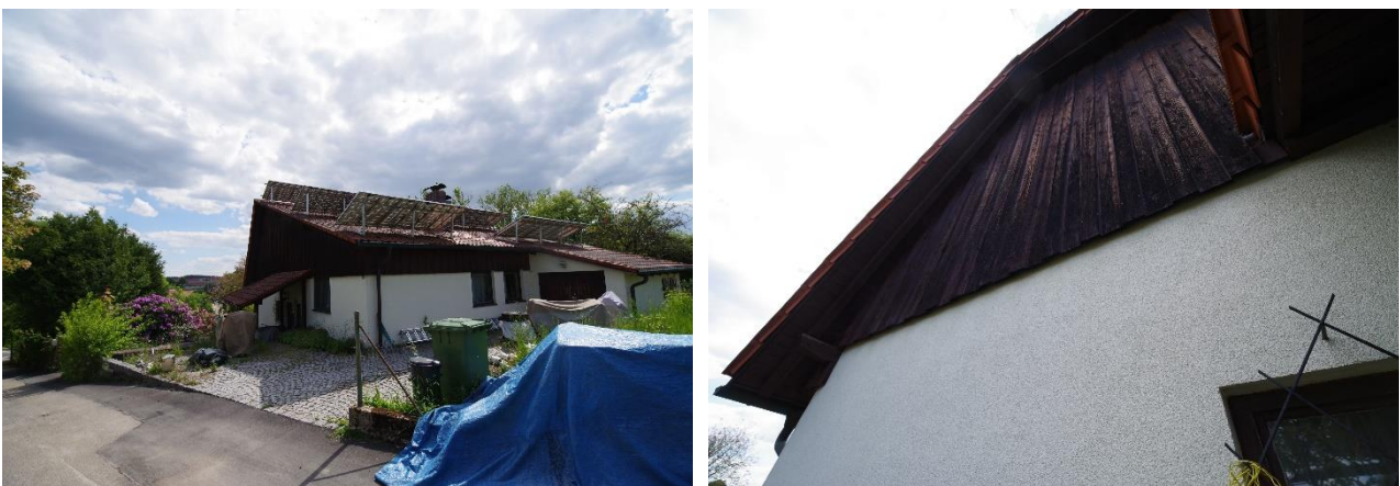
Abbildung 9: Holzverkleidung eines Wohnhauses in der Ortschaft Pettenreuth als Wochenstubenquartier der Brandfledermaus im Umfeld des fTK im Mai 2020 (A_Mbra_2).
